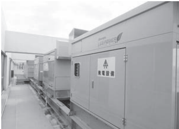
中央区の区役所本庁舎11階テラスにLPガス非常用発電機3台、LPガス50kg容器40本を導入
