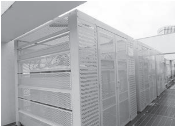
中央区の区役所本庁舎11階テラスにLPガス非常用発電機3台、LPガス50kg容器40本を導入
