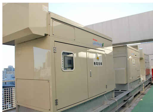
中央区役所本庁舎11階テラスに設置された26kVAのL P ガス非常用発電機3台
